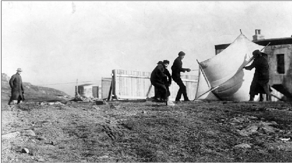
Marconi osserva la messa a punto dell'aquilone utilizzato per sollevare l'antenna a St. John's, in Terranova, nel 1901
