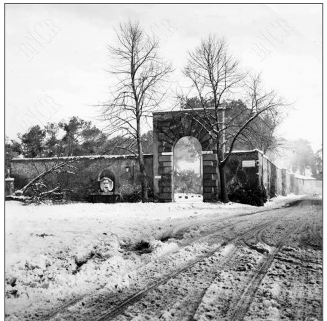
Piazza Pietro d'Iliria nel 1956 con la neve; il mascherone e la vasca a sinistra del portale di ingresso al Giardino degli Aranci
